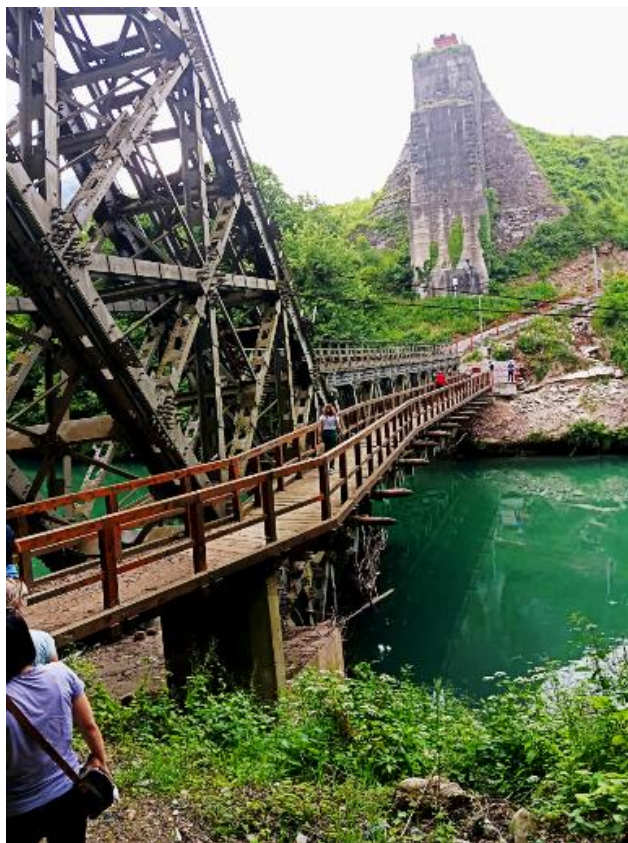
Слика 16. – Срушени мост у Јабланици (фото: Ј. Шормаз)
